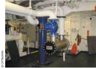
リーガル・プリンセス号に導入された、固形物分離と紫外線照射を行うオプティマリン社OPTI-MARバラスト水処理システム
