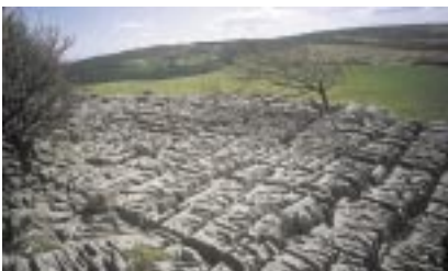
Cobertura de calcário protegida em Cumbria, Reino Unido.
