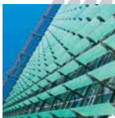
Edificio federal San Francisco
